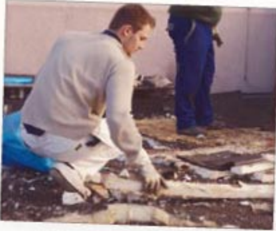
Während die Jungs auf der Baustelle noch die Reste vom alten Dach entsorgen ...
