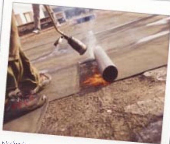
Nichtsdestotrotz werden noch an diesem Tag die ersten Bahnen der Dampfbremse auf das nackte Dach aufgebracht.
