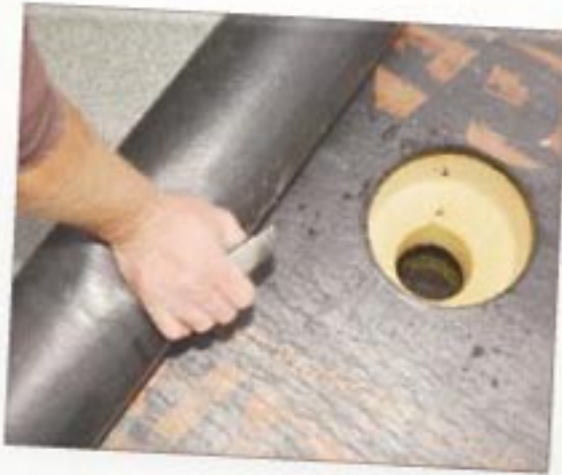
Endspurt. Natürlich darf auch das Loch für den wichtigen Abfluss nicht fehlen.
