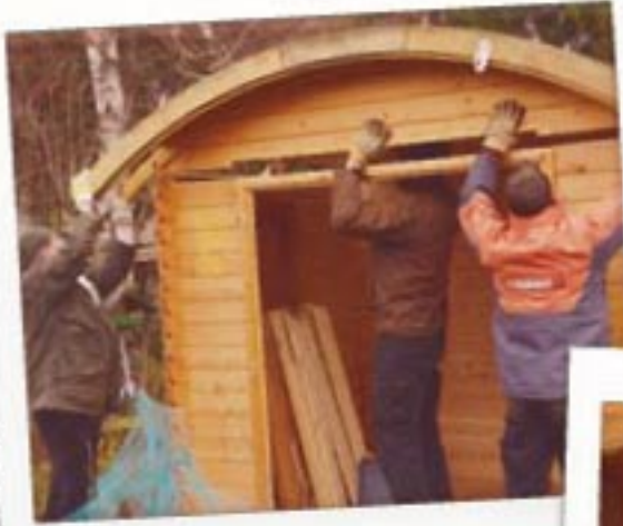
Und gemeinsam wieder das Dach montiert.
