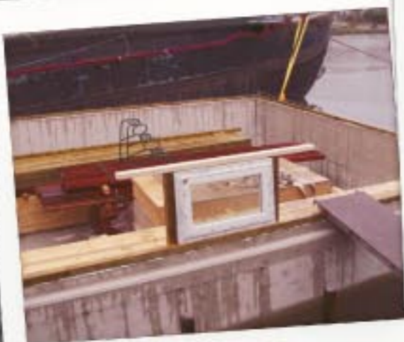
Das erste Fenster steht. Fehlen nur noch über 20 weitere, denn schön hell soll es im Inneren werden.
