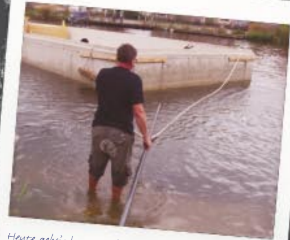
Heute geht's los. Das schwimmende Fundament für das neue Wohnboot ist da.
